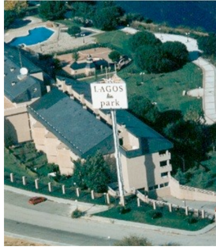
Torre tubular de telefonía con antenas ocultas por radomo
